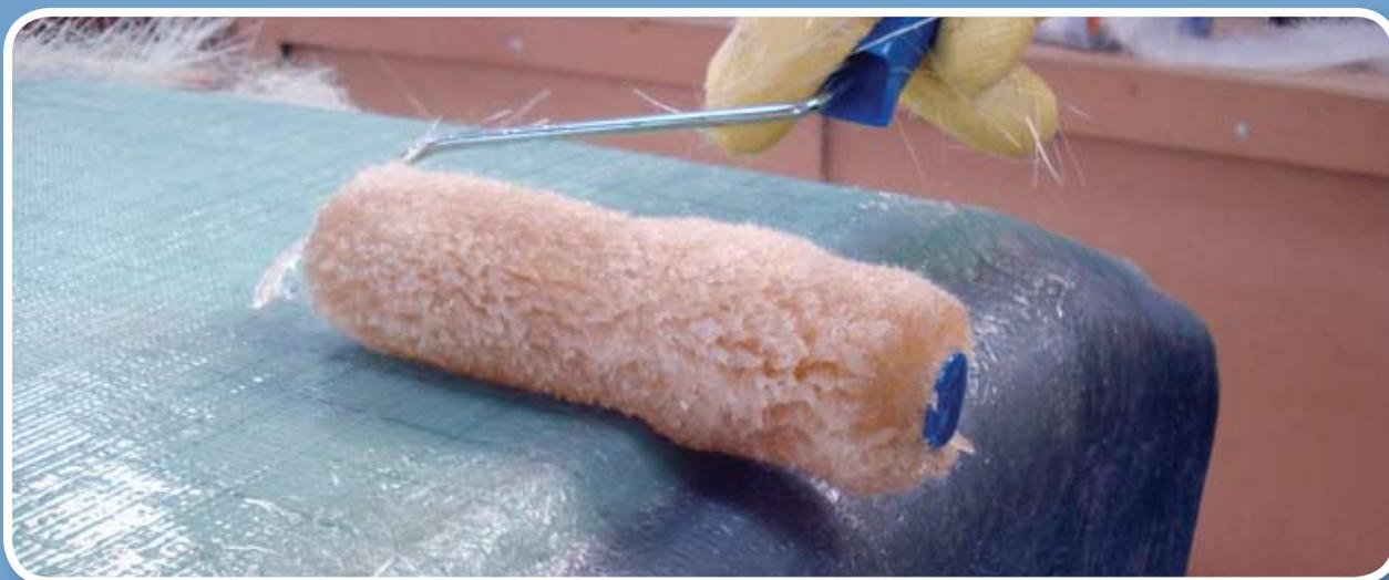
à tração e relativamente boa rigidez em relação à flexão. Os filamentos usados no laminado são produzidos num diâmetro de 14 a 22 microns. O vidro tipo E é, sem dúvida, o mais popular entre os construtores de barcos e talvez 95% de todas as embarcações de fibra do mundo sejam feitas com esse tipo de material.
